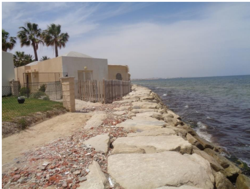
Figure 9: Mise en place d'un ouvrage d'enrochement pour protéger les aménagements affectés par l'érosion (la situation en 2015) (photo, F. Brahim).
