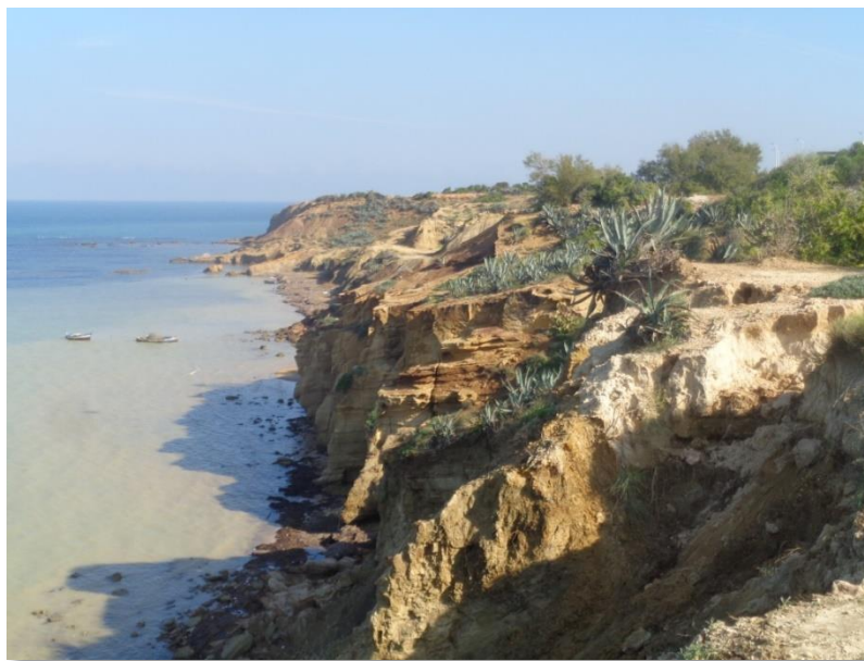
Figure 3: La falaise de Monastir taillée dans les couches d'argiles et de sables miocènes (photo, F. Brahim, 2017).
