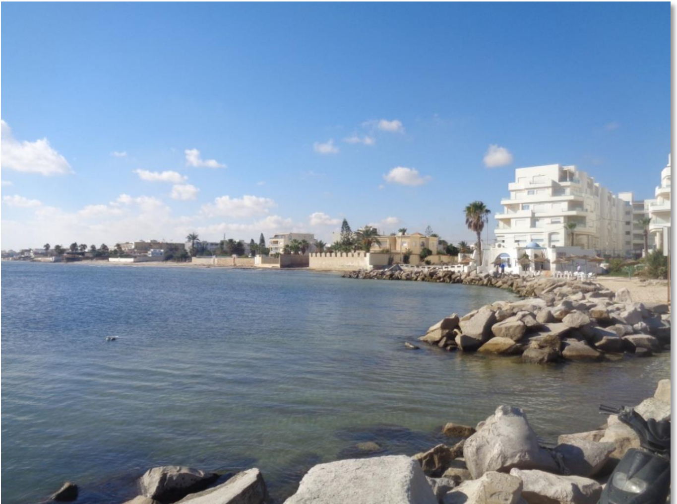
Figure 10:Epis et enrochements implantés au Sud d’El Kantaoui, ces ouvrages ont sauvé les aménagements menacés mais ils ont aggravé l’érosion des segments situés plus loin vers l’aval (photo, F. Brahim, 2017).
