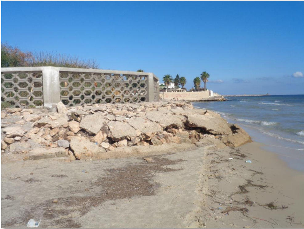
Figure 4: Impact de l'aménagement du port d'El Kantaoui sur le secteur situé au Sud : érosion affectant la plage et les aménagements de front de mer à cause de la privation de ce secteur des sédiments retenus au Nord du port (photo, F. Brahim, 2017).
