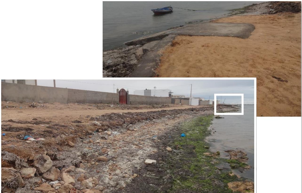
Figure 7: Constructions de front de mer et tentatives de protection par tous les moyens possibles. Au premier plan, on utilise, entre autres, des pierres provenant des vestiges archéologiques dispersés par les vagues (photo, A. Oueslati, 2017).
