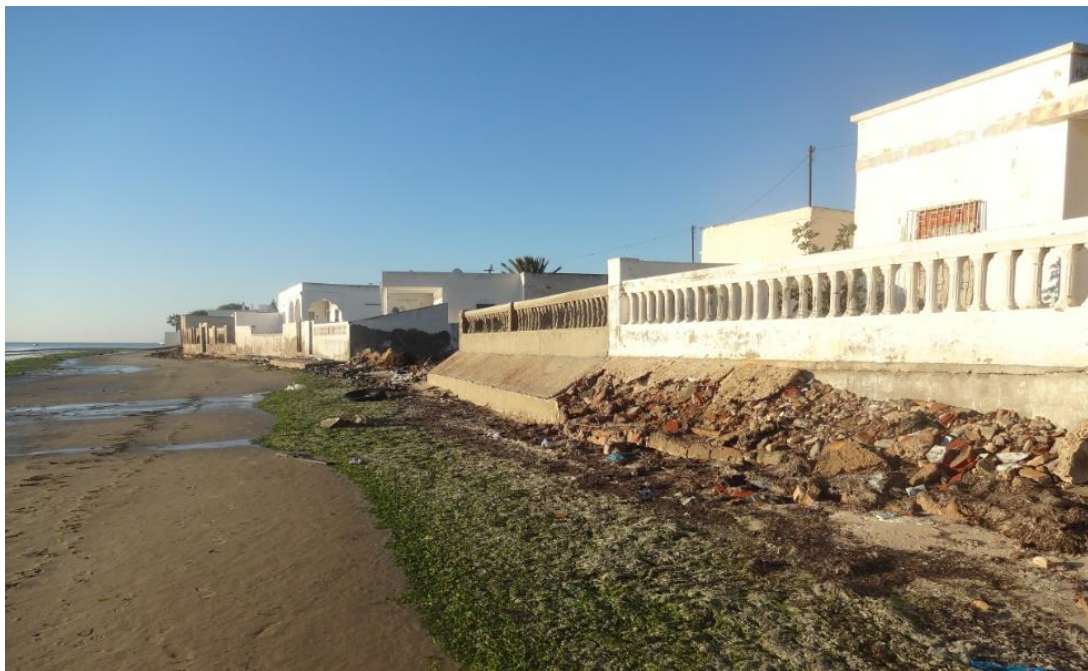
Figure 8: L'état de la côte sur la face nord du petit promontoire de Sidi Mansour ; photo prise par marée basse (photo, A. OUESLATI, 2017).
