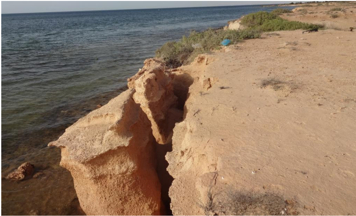
Figure 14: Falaise taillée dans les argiles mio-pliocènes et évoluant par éboulement : face ouest de la presqu'île de Jorf (photo A. Oueslati).
