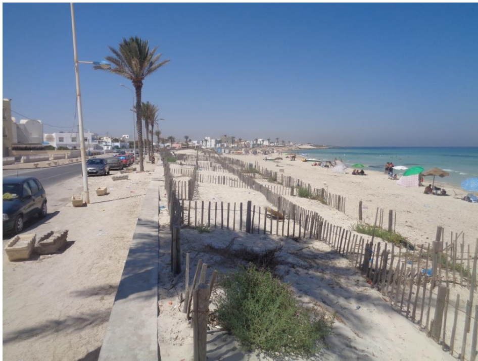
Figure 42: La fixation de la dune bordière de la plage d'Essir à Chebba par les ganivelles. On aperçoit les haies en lattes de bois implantés pour piéger les sables manipulés par le vent (photo, F. Brahim).
