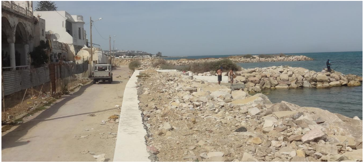
Figure 41: - L'un des premiers secteurs à faire l'objet d'une protection lourde : enrochements et épis dans la banlieue nord de Tunis (photo, A. Oueslati)
