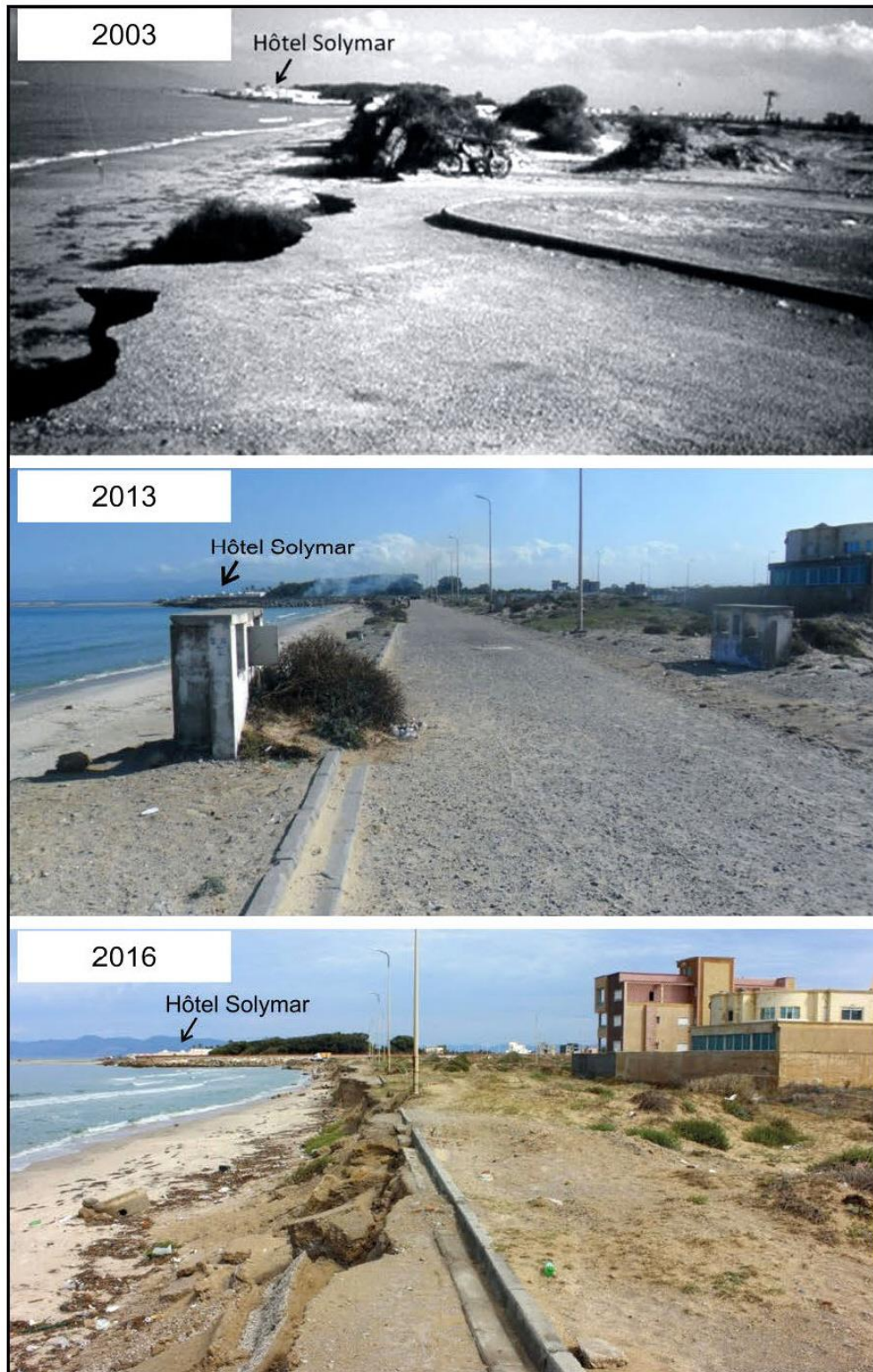
Figure 39: - La situation à Ejjeimi : l'une des illustrations les plus expressives de la rapidité avec laquelle agit l'érosion lorsque la dynamique naturelle est dérégulée par des interventions imprévoyantes (source : Marzougui W. et Oueslati A., 2017).
